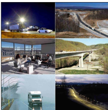
Рис 5. Элементы "умной дороги". Вирджиния, США
